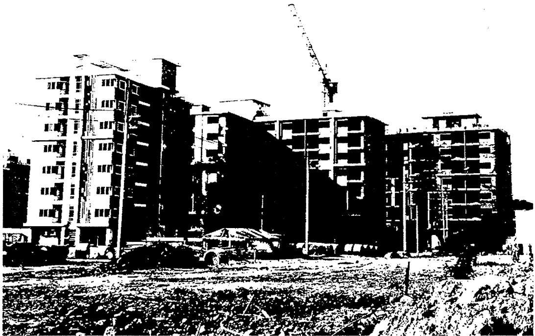
ขบเซา - ปัญหาการเมืองและราคาพืชเกษตรตกต่ำ จุดให้กำลังซื้อภาคใต้โดยรวมถดถอยและส่งผลกระทบต่อเมืองมายังภาคธุรกิจ อสังหาริมทรัพย์ใน อ.หาดใหญ่ช่วงต้นปีขบเซาลงทั้งคอนโดและบ้านเดี่ยว
