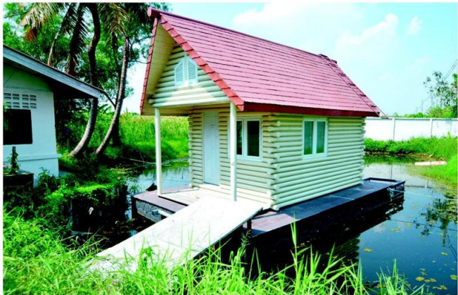
บ้านลอยน้ำ
