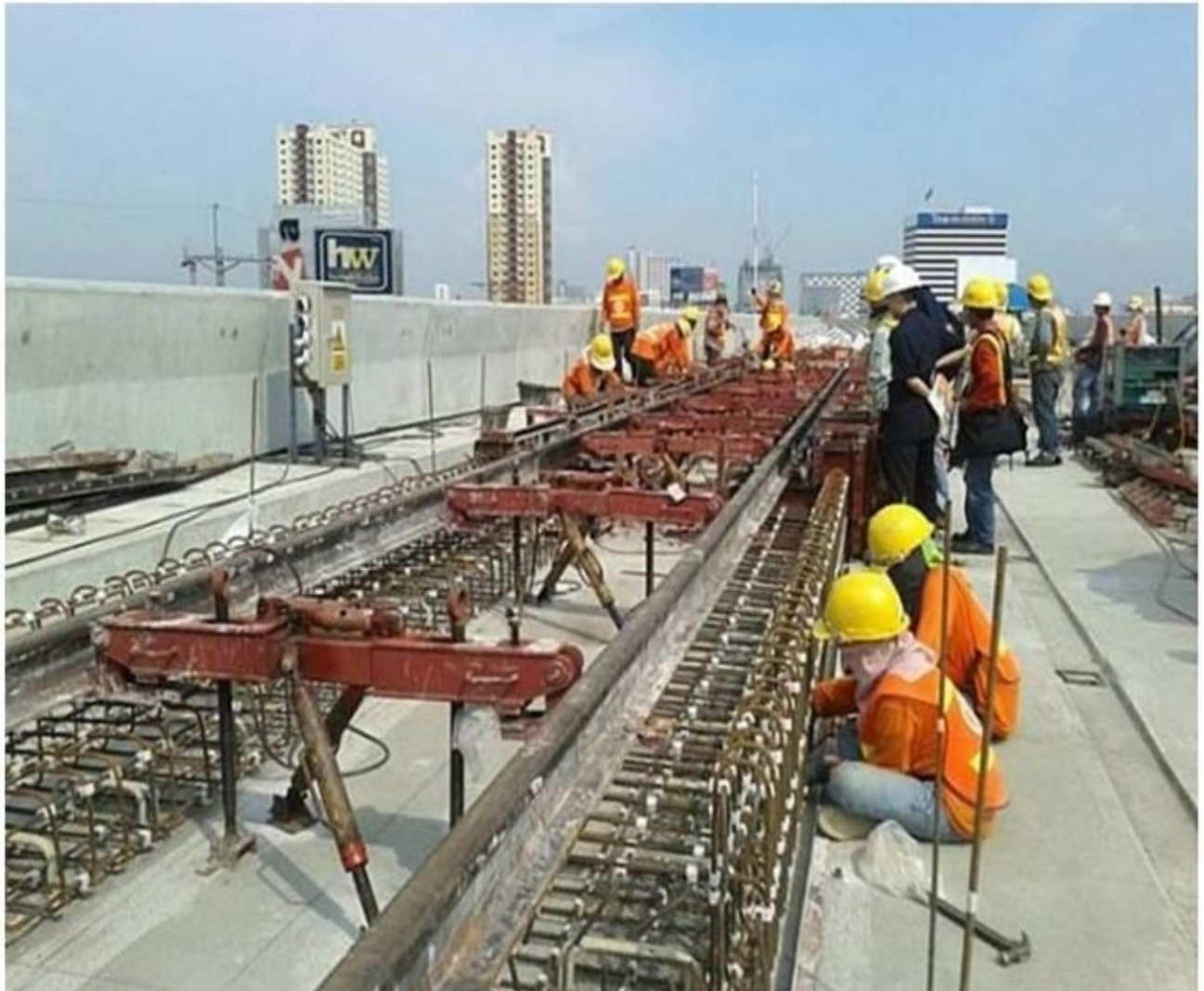
งานก่อสร้างระบบราง
