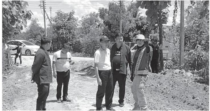
นายก อบจ.เชียงใหม่ติดตามตรวจงานโครงการพัฒนาถนนเพื่อปรับปรุงเส้นทางคมนาคมในพื้นที่ เพื่อแก้ไขปัญหาการจราจรคับคั่ง.
