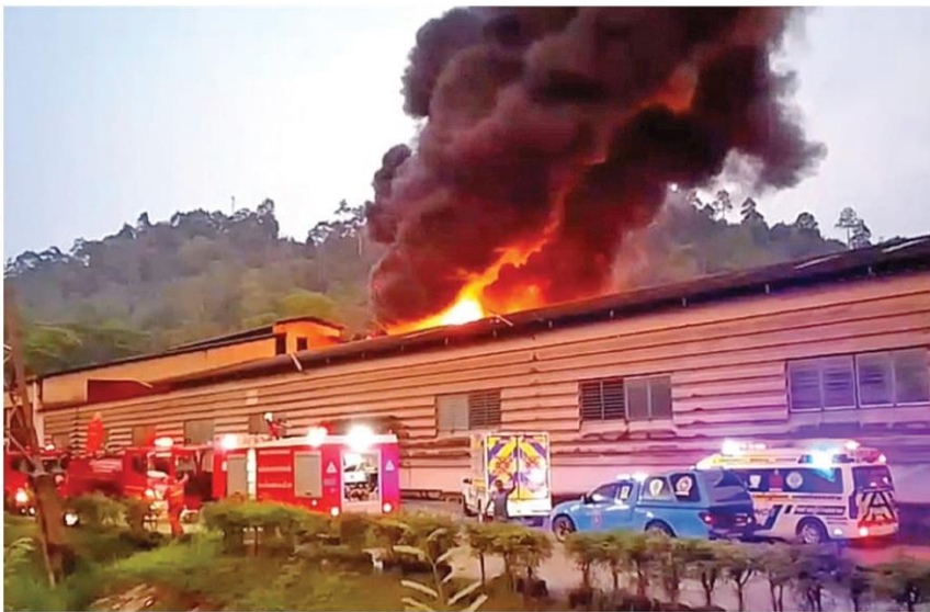
🏠 ไหม้ 10 ซม. - เพลิงไหม้โรงงานบริษัท ยูนิ-รับเบอร์ จำกัด ริมถนนสายเอเชีย อ.ทุ่งสง จ.นครศรีธรรมราช ผู้ผลิตยางพาราแผ่นและแท่งรายใหญ่ระดับประเทศ เจ้าหน้าที่ใช้เวลาข้ามคืนกว่า 10 ชั่วโมง ควบคุมเพลิงได้ คาดสาเหตุเกิดจากความร้อนในห้องอบยาง
