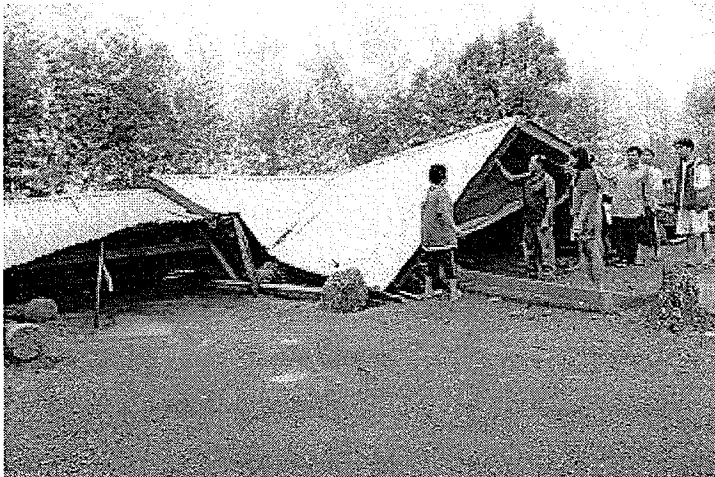
ฤทธิ์พายุ - พายุฤดูร้อนซัดถล่มบ้านเรือนประชาชน ที่บ้านทุ่งมน ต.เชียงเครือ อ.เมือง จ.สกลนคร จนพังครืนลงมาทั้งหลัง ขณะที่อีกหลายจังหวัดในภาคอีสานและเหนือ ต่างก็ประสบภัยพายุฤดูร้อนเช่นกัน เมื่อวันที่ 4 พ.ค.
