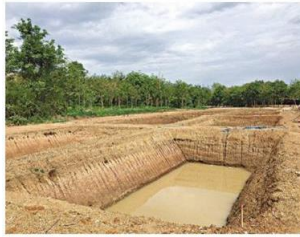
สร้างบ่อน้ำบาดน้ำเสีย
