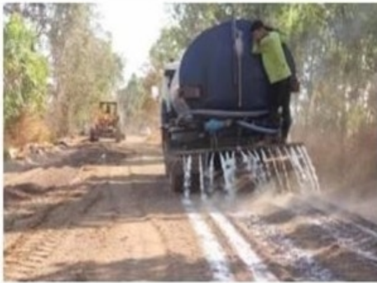
การรดน้ำยางพาราบนถนนดินลูกรัง
