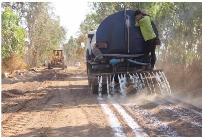
การปรับปรุงถนนลูกรังให้เป็นถนนพาราซอยด์ซีเมนต์ที่ อ.เสภา จ.บึงกาฬ เมื่อปี 2560 ที่มาภาพ: มติชนออนไลน์
