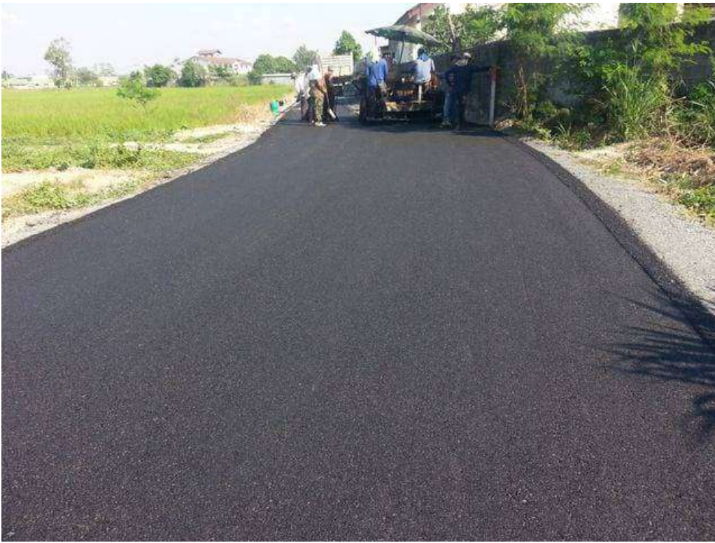
การใช้ยางพาราในการทำถนนยางพาราซอยซีเมนต์
