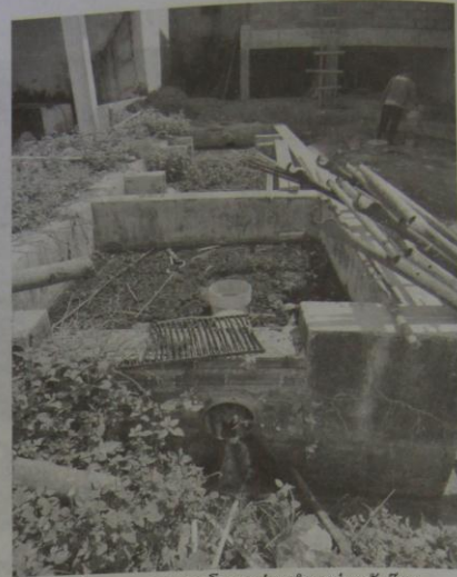
บ่อที่กักก๊ากก่อนจากโรงรมก่อนนำลงบ่อหมักก๊าซ
