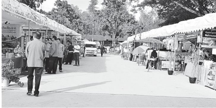
สภาพถนนจากการใช้น้ำยางพาราดิบเป็นส่วนผสมสำคัญ ช่วยทำให้ถนน ถาวร ที่บริเวณด้านหน้าสำนักงานเทศบาล ต.ห้วยซ้อ อ.เชียงของ จ.เชียงราย.
