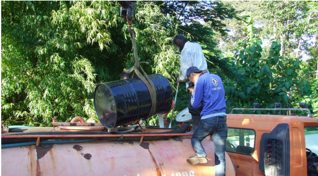
2.5 ใช้รถบรรทุกน้ำ พ่นสเปรย์น้ำผสมน้ำยาฟอสฟอรัสเพิ่มที่ได้เตรียมไว้แล้ว
