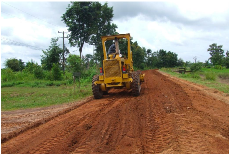
ภาพประกอบ คู่มือแนะนำการก่อสร้างถนนดินซีเมนต์ปรับปรุงคุณภาพด้วยยางธรรมชาติ สำหรับงานถนนท้องถิ่น
