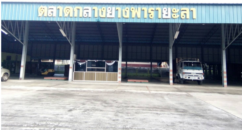
แผนภาพที่ 5 อาคารให้บริการตลาดกลางยางพาราจังหวัดยะลา
